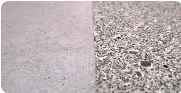
links: „normaler“ Schalungsglatte Beton
