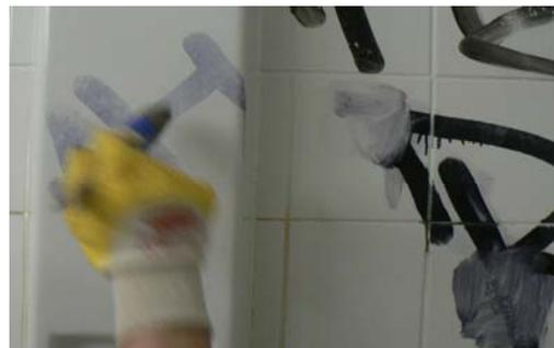
Bild oben rechts Graffiti wird sofort gelöst. Links muss mit Oxydizer Schattenbleiche nachbehandelt werden.
