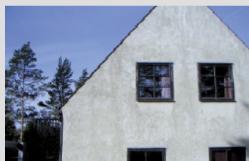
Façade avant la rénovation
