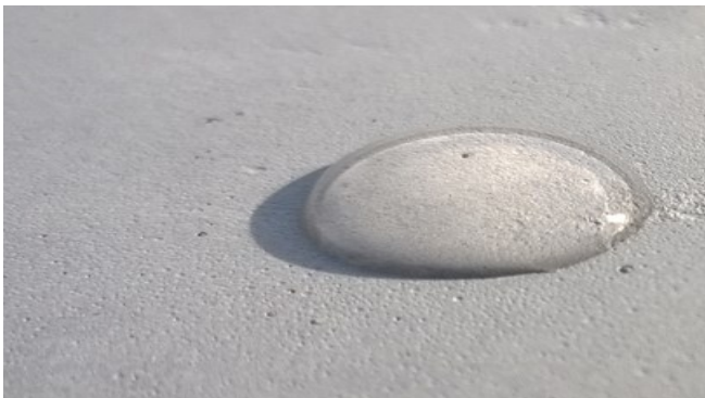
Sichtbeton mit COLORTEC® finish
