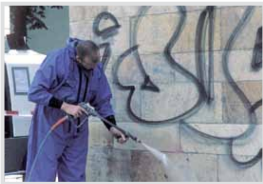
Sanftes Strahlwaschen zur Graffiti-Entfernung auf Sandstein.
