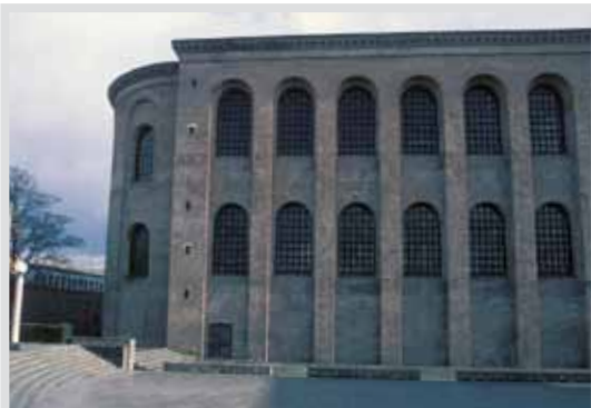
Konstantin Basilika: Apsis, Ziegelmauerwerk mit m.a.c.s.® Graffiti-Imprägnierung geschützt.
