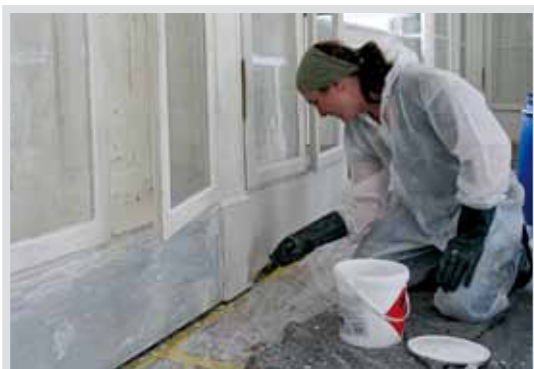
Freilegung von Ölfarbanstrichen für einen neuen Beschichtungsaufbau.
