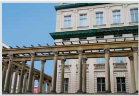
Abbeizen auf Fassadenstuck und Naturstein.
