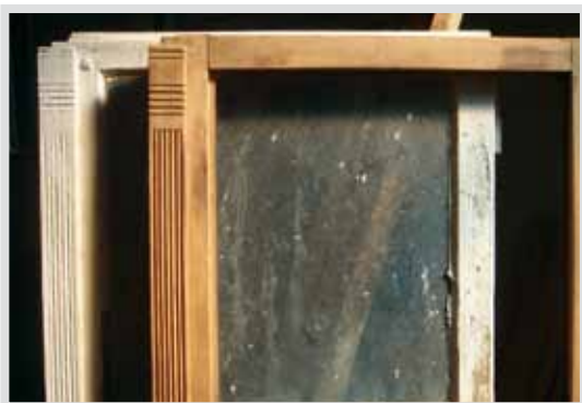
Abbeizen auf Holzoberflächen.
