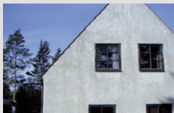
Objekt vor der Sanierung
